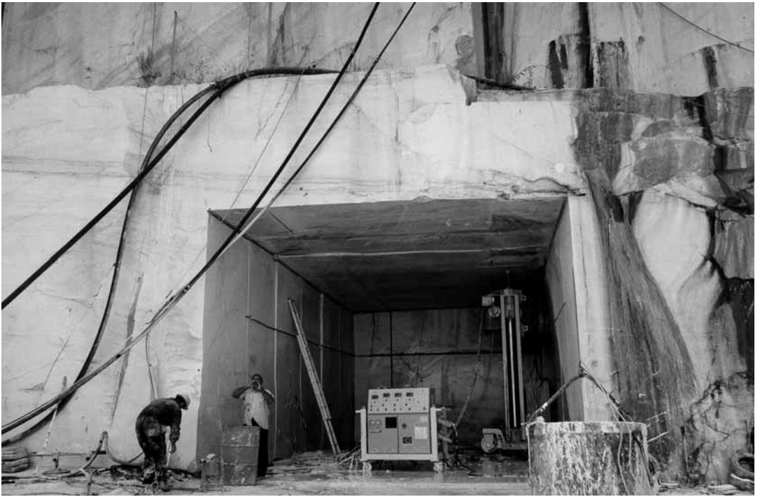
Fig. 8 Cava di Lugamar: avanzamento della galleria dopo tre mesi
