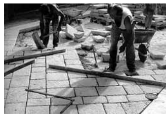
Fig. 25-26 Elementi architettonici in pietra leccese per l'arredo urbano
