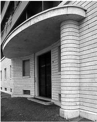
Fig. 11 Roma. Lungotevere Flaminio, ingresso di un edificio residenziale con rivestimento di travertino listato.
